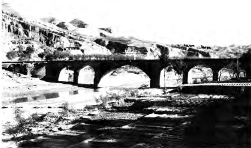
白家川无定河大桥
