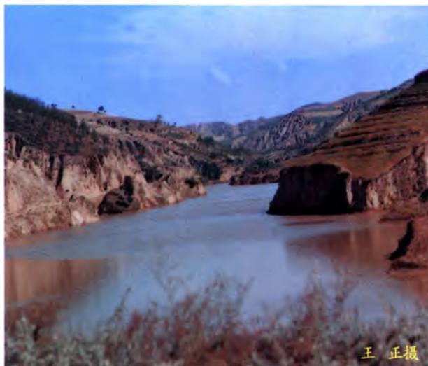
县城供水工程水源地之一老柳卜坳水库
