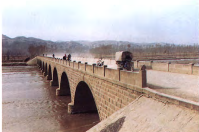
镇川河神庙无定河大桥
