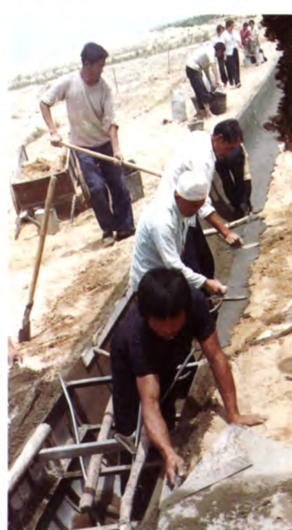
沙地修U型水渠
