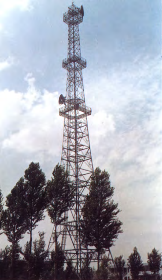
麻黄梁电信微波铁塔
