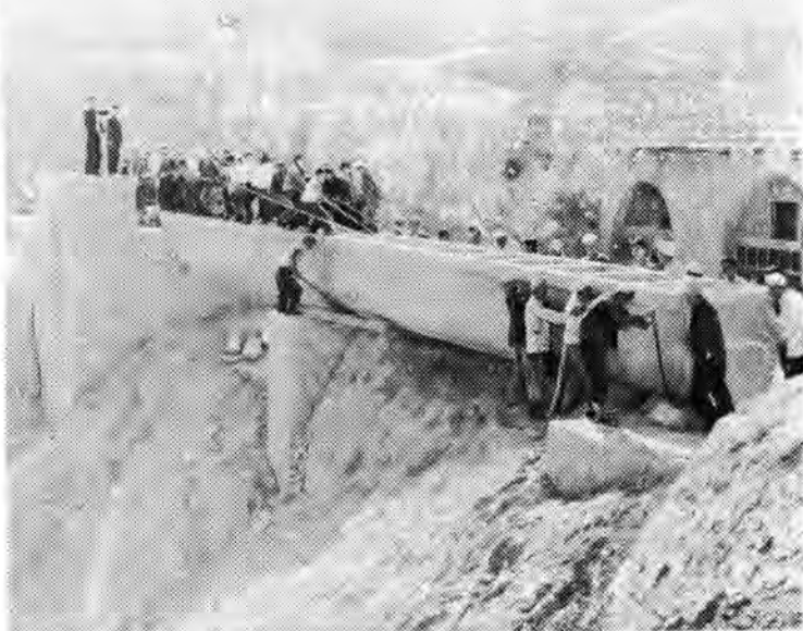
榆高渠架设渡槽
