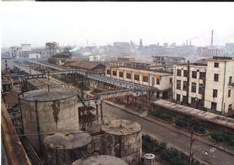
50年代建设的化工原料生产企业——西安化工厂厂区。
