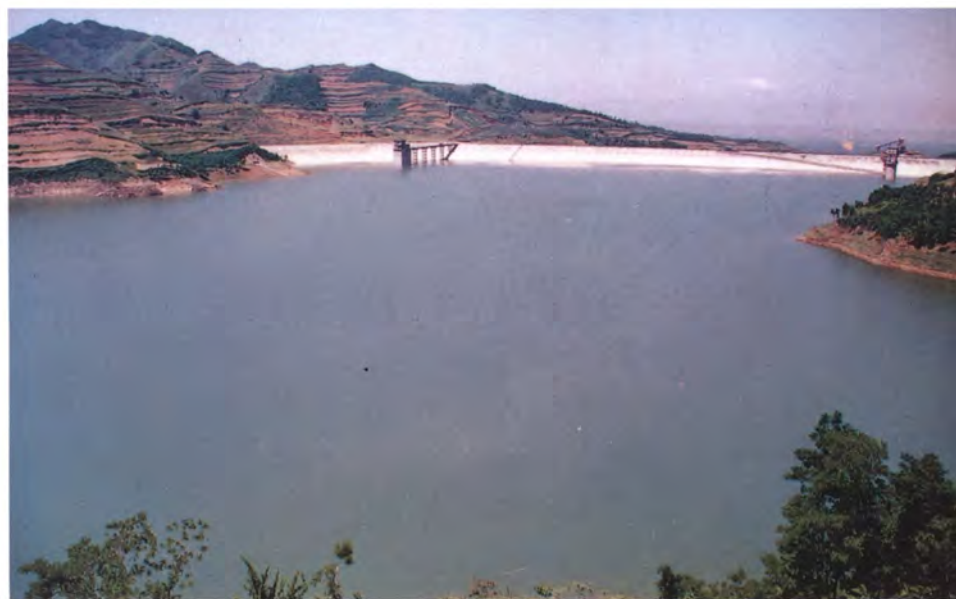
1969年开工,1985年建成的眉县石头河水库,总库容1.25亿立方米,是以蓄水灌溉为主,兼有防洪、发电功能的中型水利工程。
