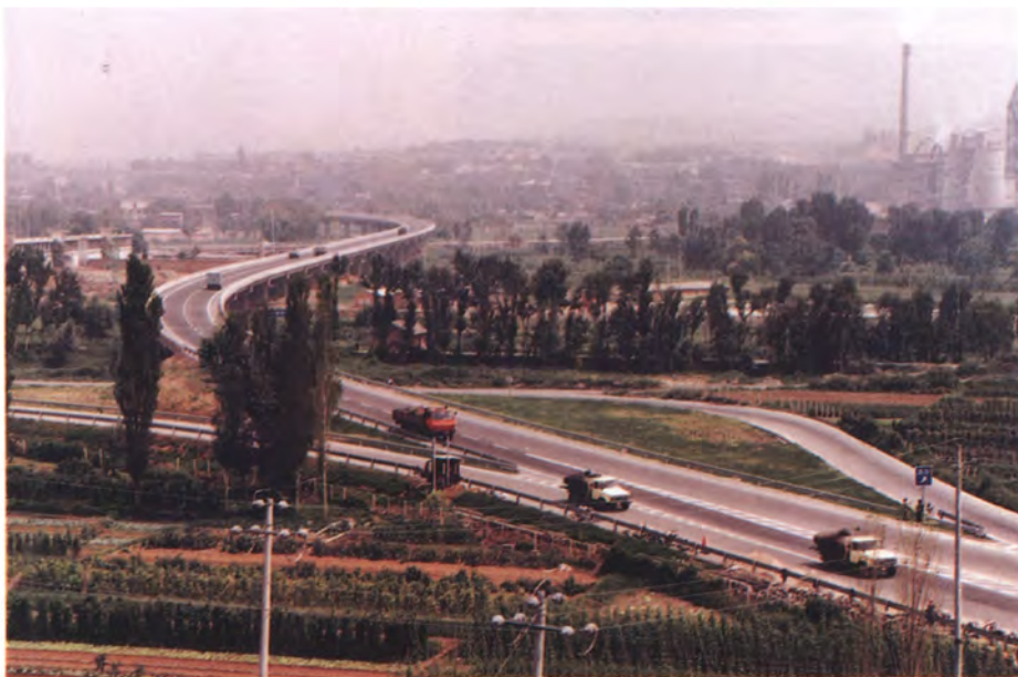
1990年开工建设的 三原—铜川一级公路。 图为耀县城区段的高架桥。
