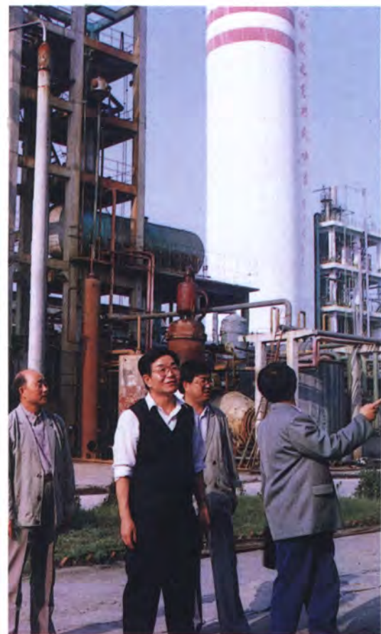
建设银行汉中地区中心支行领导在城固氮肥厂了解扩建工程进度。
