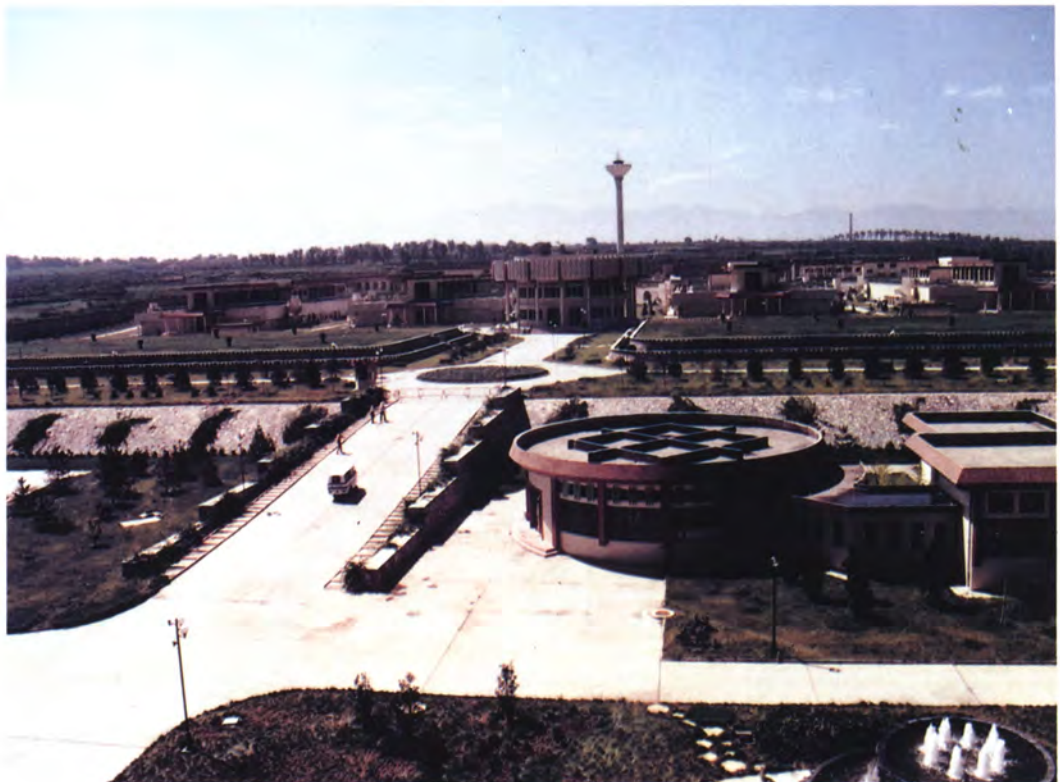
为缓解西安市区供水紧张状况建成的黑河引水工程曲江水厂,日净水60万立方米。
