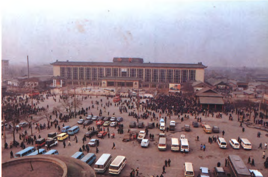
1985年12月改建、扩建后的 西安火车站。
