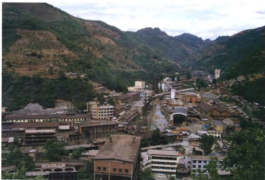
60年代建设的略阳钢铁厂全貌。
