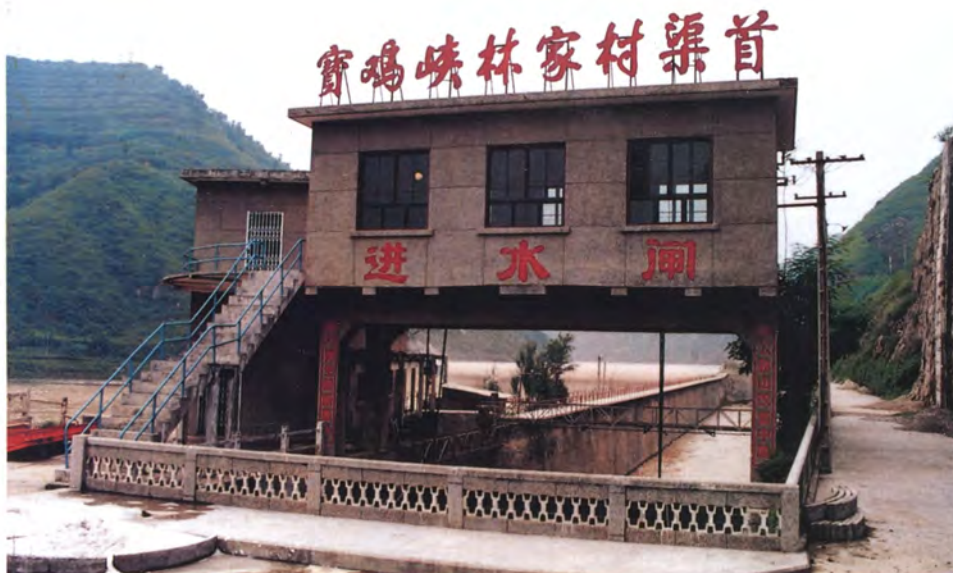
1971年7月竣工的宝鸡峡引渭灌溉工程,可扩灌耕地270.3万亩。图为渠首进水闸。
