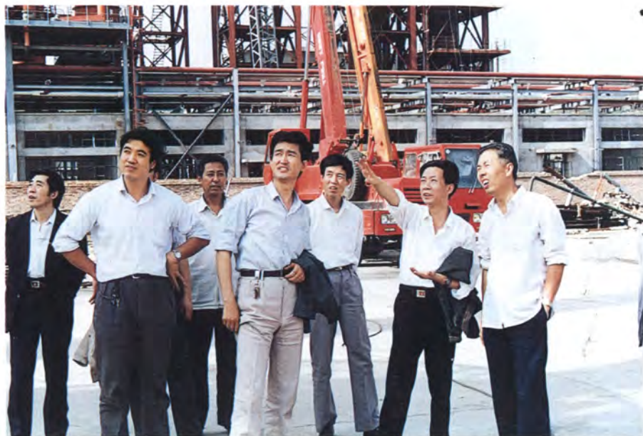
1991年,建设银行陕西省分行主持工作的副行长陈金友(右二)在延安炼油厂工地检查设备安装进度。
