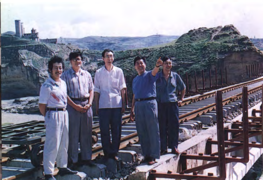
建设银行榆林地区中心支行领导到神(木)朔(县)铁路府谷段工地了解工程进度。
