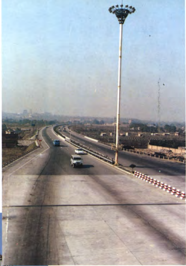
1990年建成的西安— 临潼高速公路
