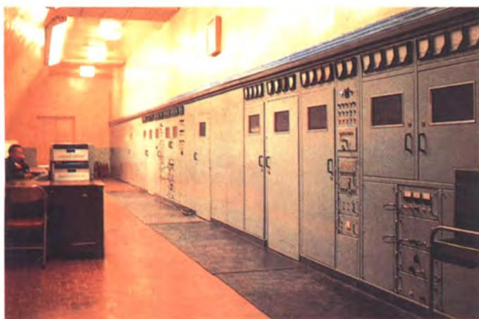
◁陕西天文台长波授时台发射机主控大厅。由此发出的长波信号为我国空间科学技术、国防战略武器试验及其它应用部门提供高精度的时频服务
