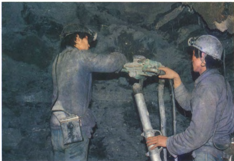
▷桑树坪煤矿普掘工作面
