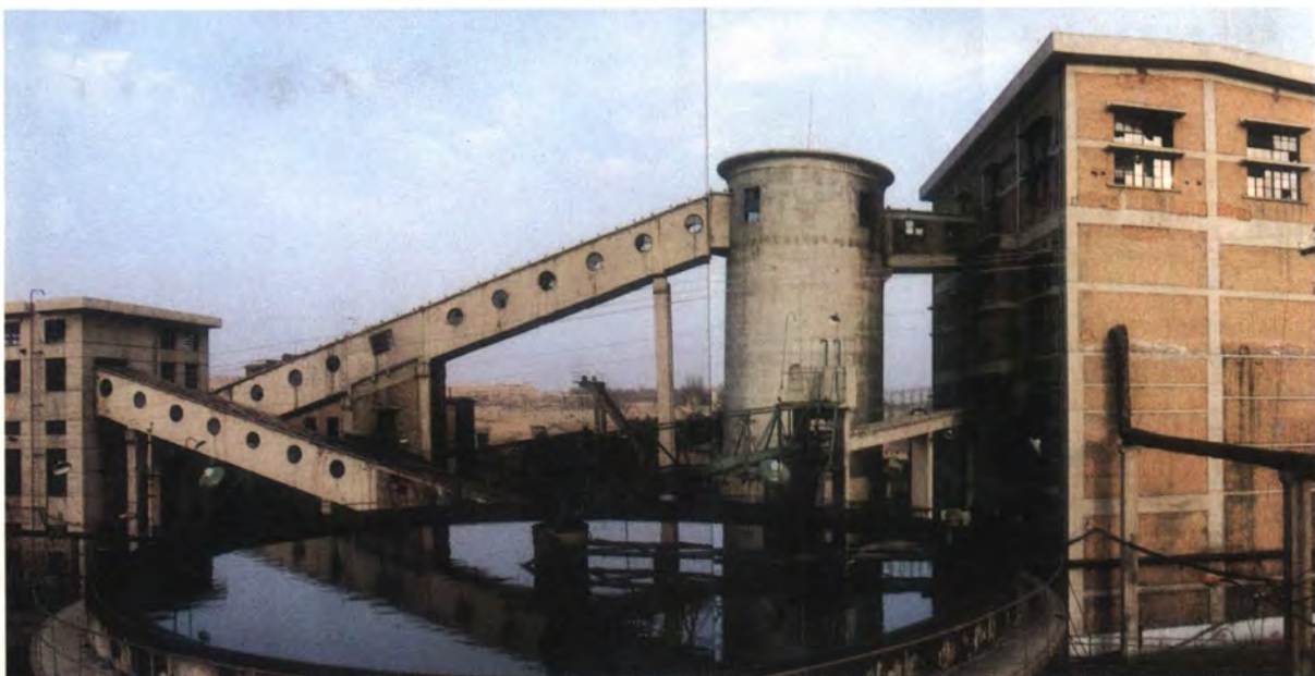
△澄合矿务局二矿 60万吨/年洗煤厂
