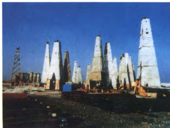
△矿井地面注浆堵水施工
