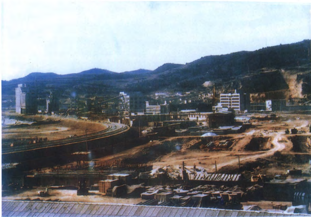
正在建设中的黄陵矿区
