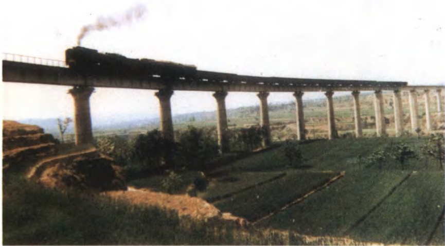
△澄合矿区运煤列车正通过洛河大桥
