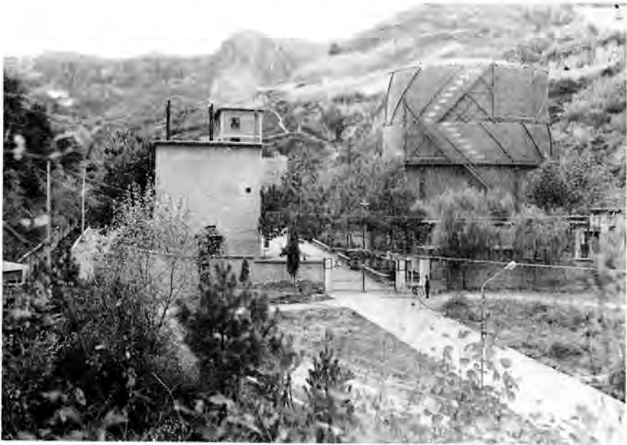
陈家山矿煤气站 10—1
