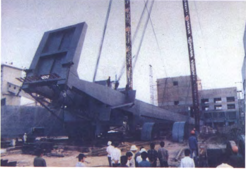
王村矿主井架整体吊装
