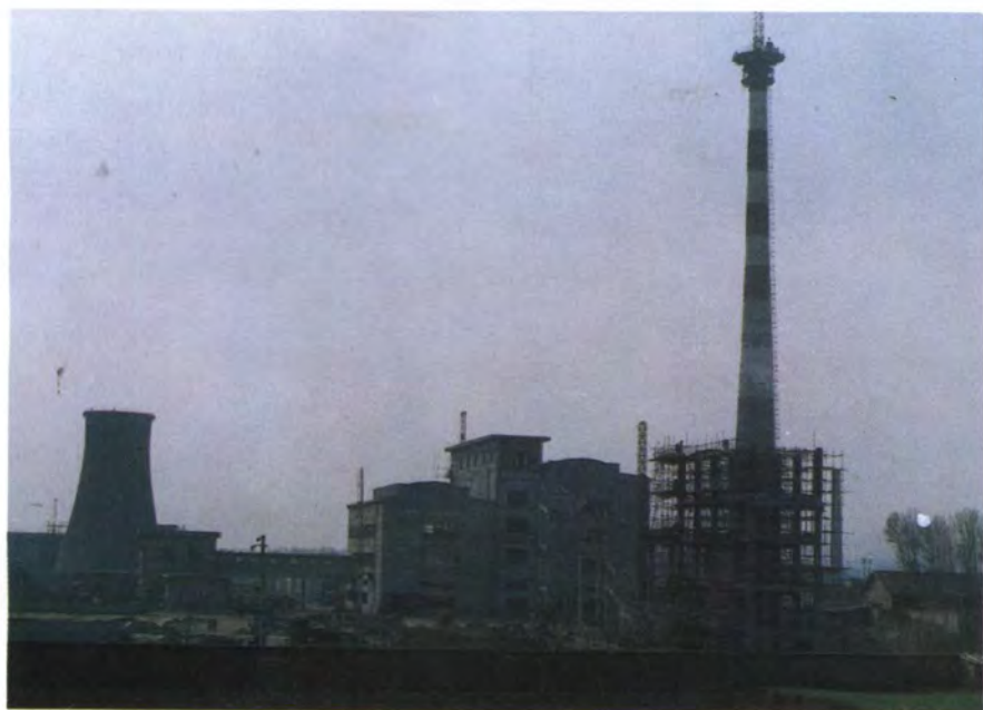
◁即将竣工的蒲白矿务局矸石发电厂
