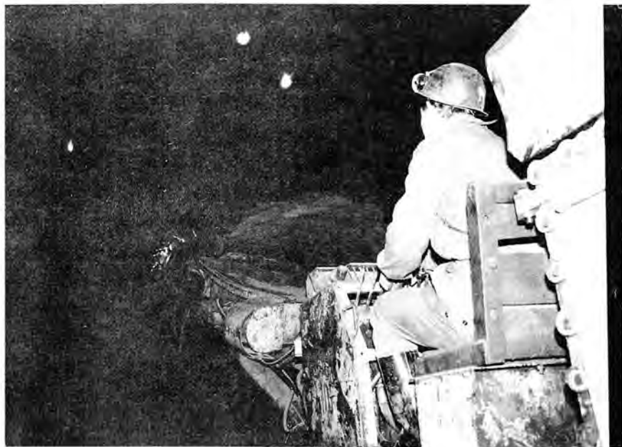
综合掘进机施工 4-2
