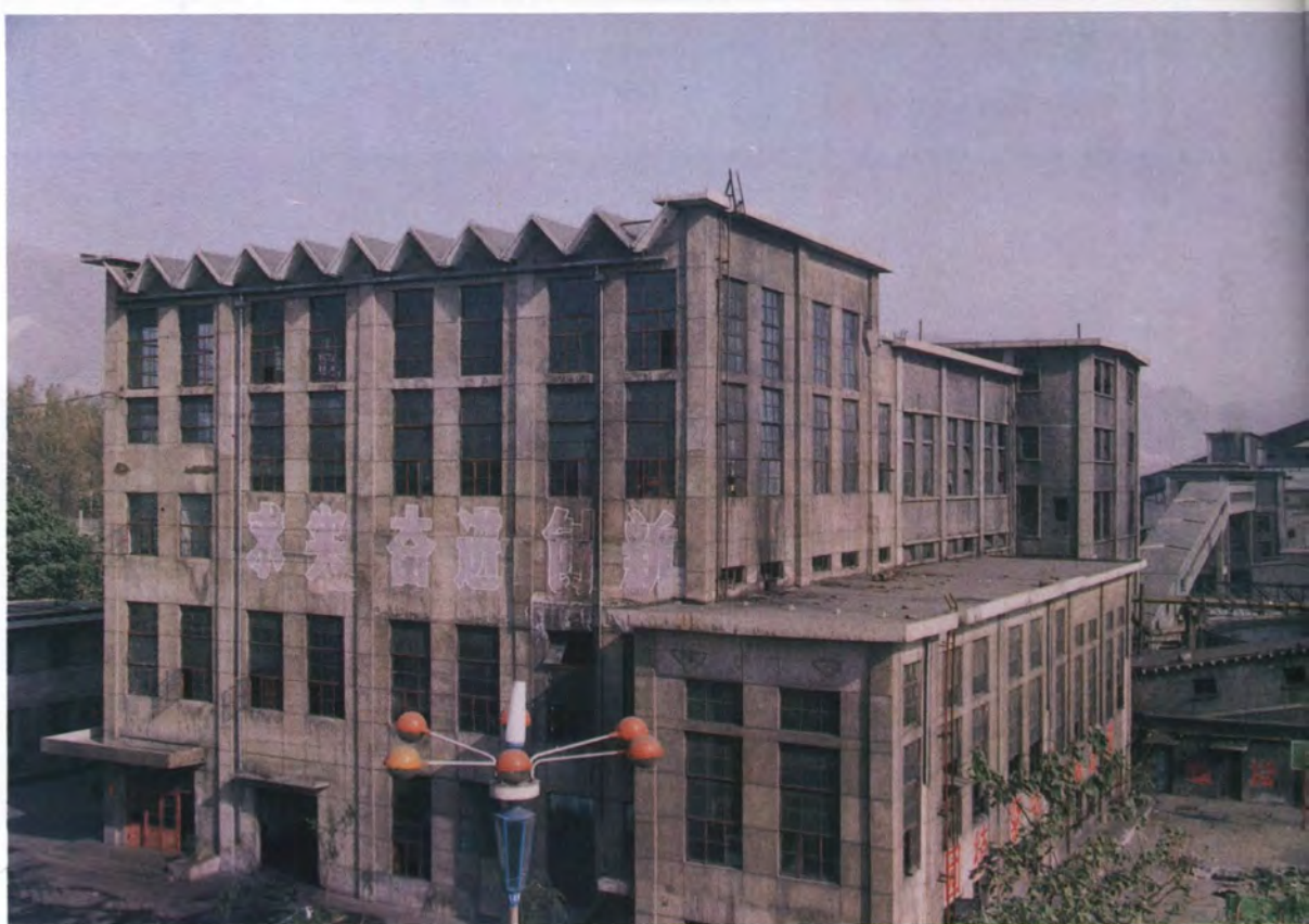
下峪口煤矿地面生产系统
