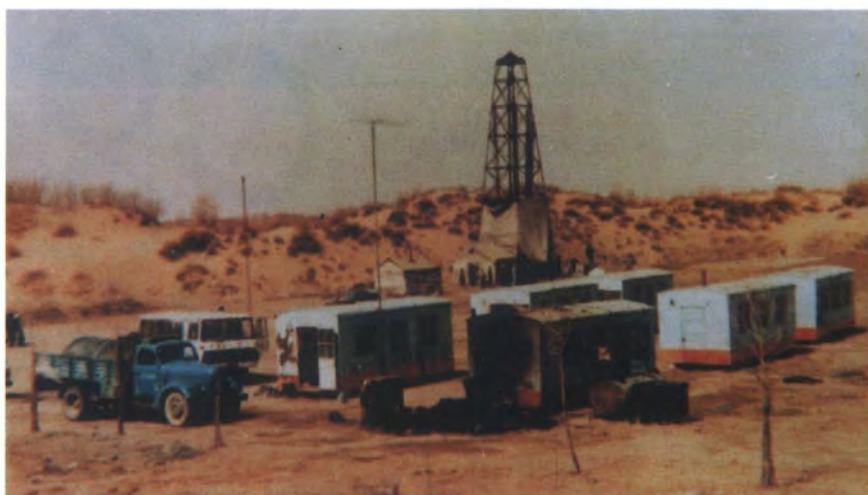
煤田钻探施工现场
