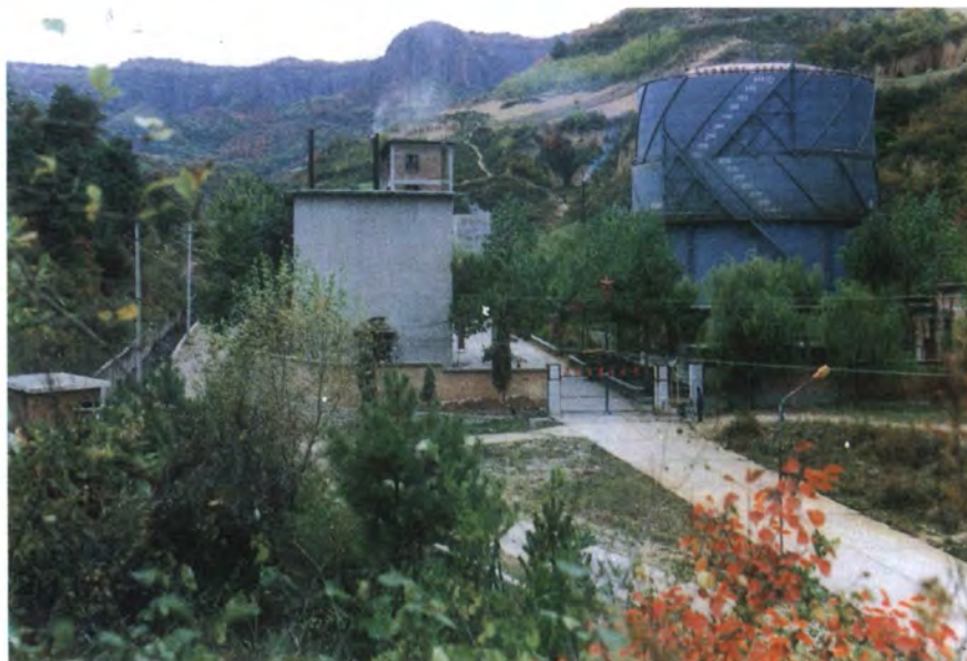
▷陈家山矿煤气站
