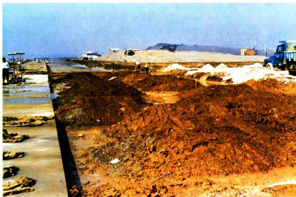
西安·咸阳机场一期工程修筑中的机场跑道
