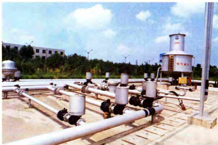
1991年建成的 西安·咸阳机场油 库高精度流量计量 检定系统。
