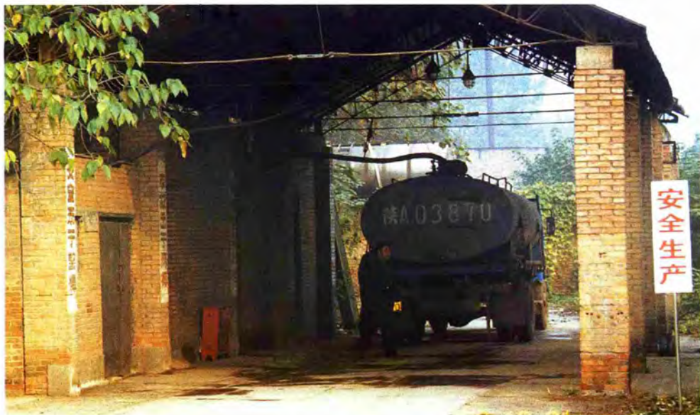
70年代建成的西安机场航空煤油库的高架罐正在给运油车供油。
