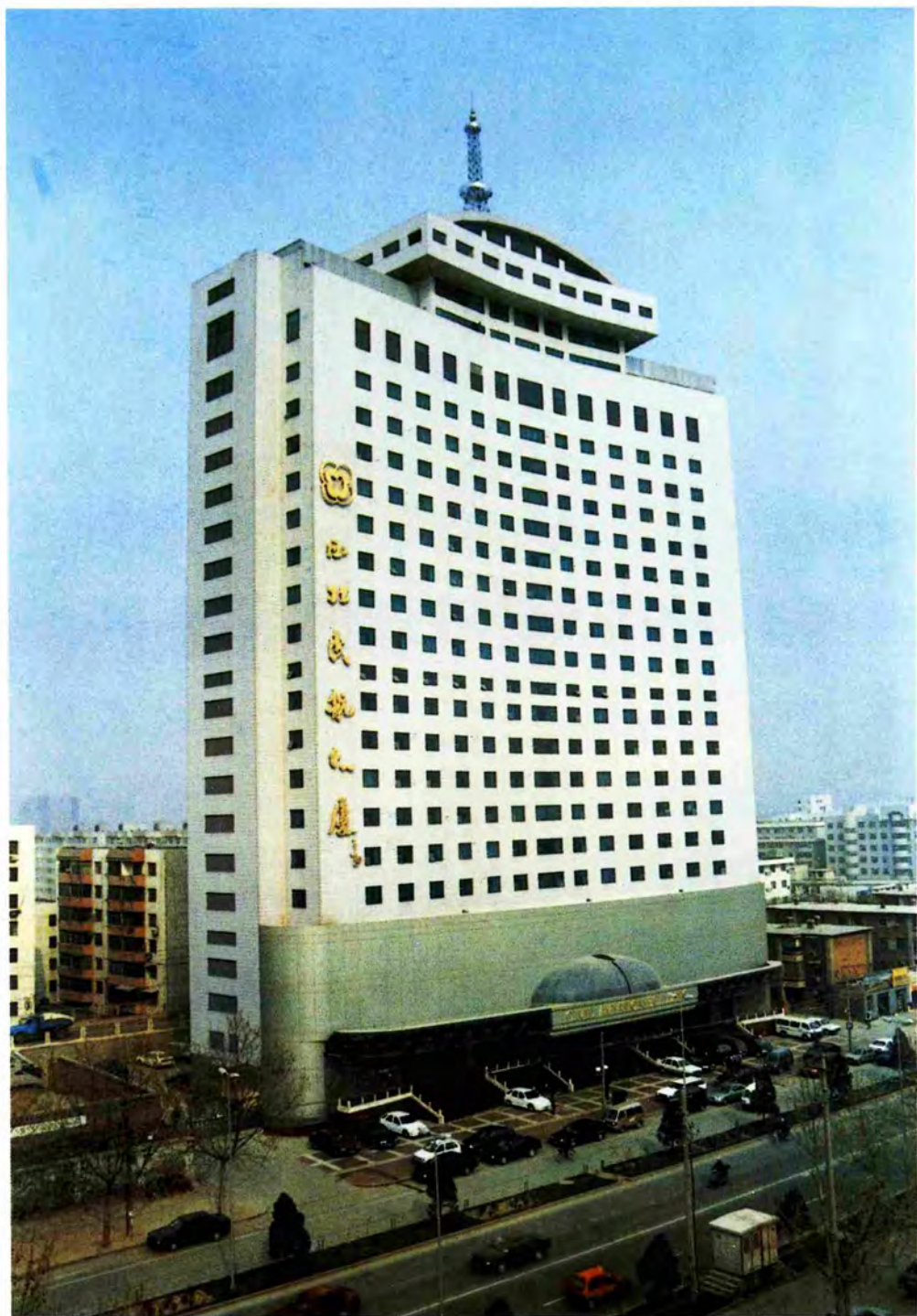
90年代末期建成的位于劳动南路北段西侧的西北民航大厦
