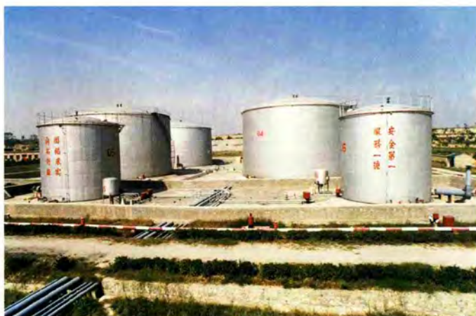
1991年建成的 西安·咸阳机场长 陵储油库区。
