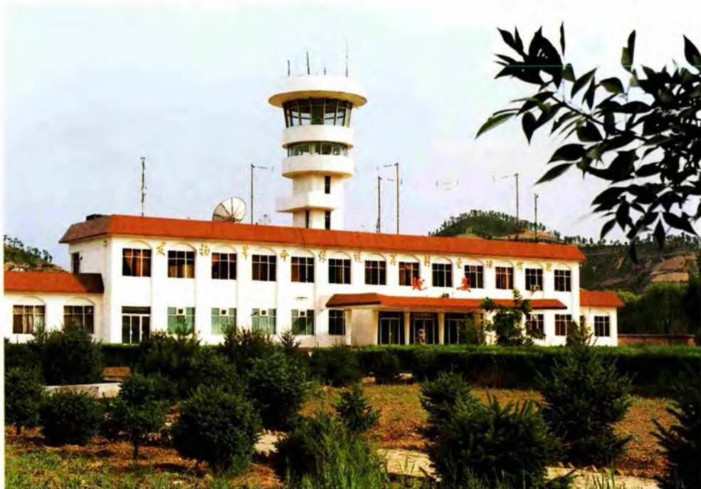
80年代建成的延安（甘里铺）机场候机楼
