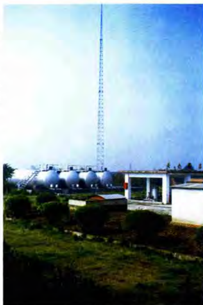
90年代初期建成的安康机场航空油库
