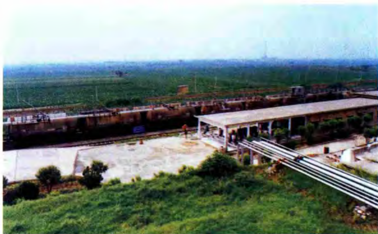
1991年建成的 西安·咸阳机场长 陵油库铁路油槽车 卸油站区。
