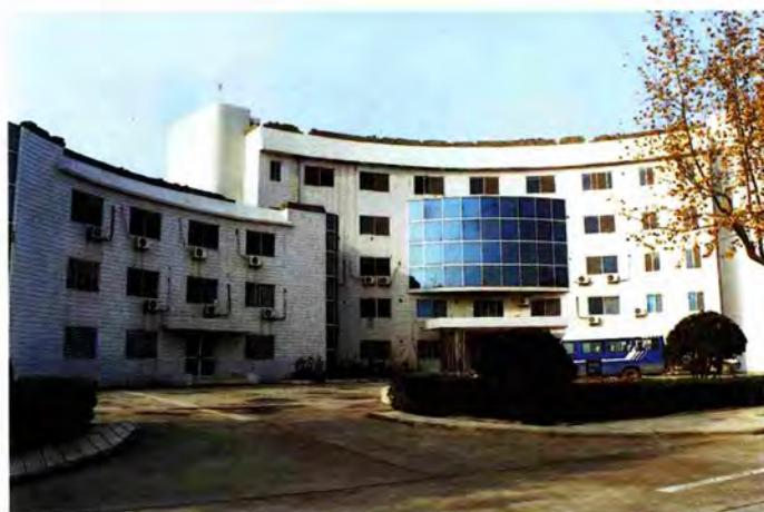
西北航空公司在西安·咸阳机场内修建的公司值班楼。
