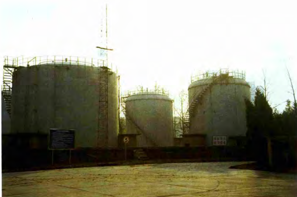
70年代中期和80年代初期建成的西安机场600立方米和2000立方米航空煤油立式油罐。
