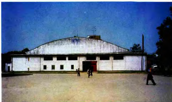
民国时期(1948年) 修建的西安机场飞机维 修库。
