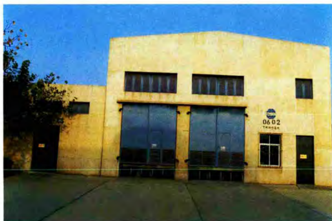
西北航空公司配电 站。（咸阳机场内）
