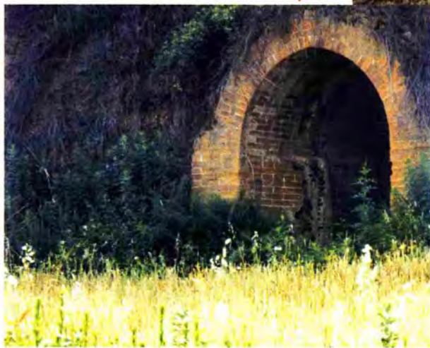
40年代建成的安康 U型土油筒库遗址。 (2 × 2.5 × 25米)
