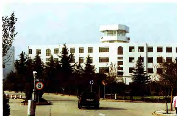
西安·咸阳机场内的飞机维修厂办公楼。
