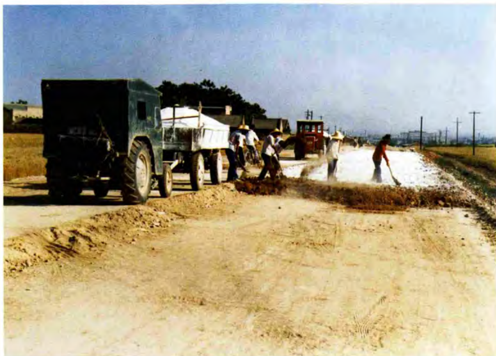
西安·咸阳机场一期工程修筑中的进场公路
