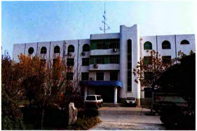
内机务特检楼。 西安·咸阳机场
