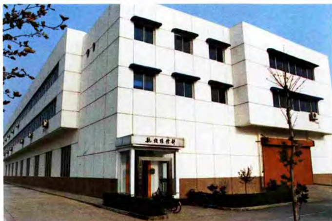
西安·咸阳机场 内航空公司航线维修 部。
