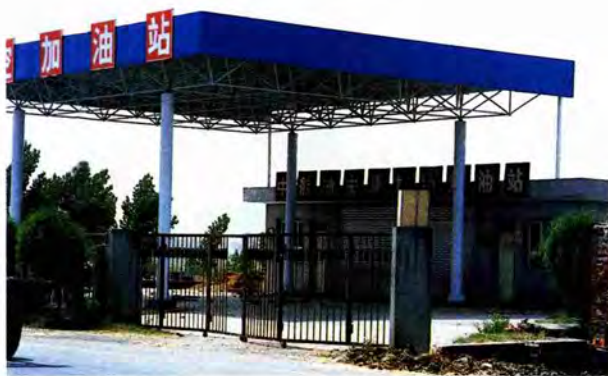
90年代建成投产的安康机场经营性的地面加油站。
