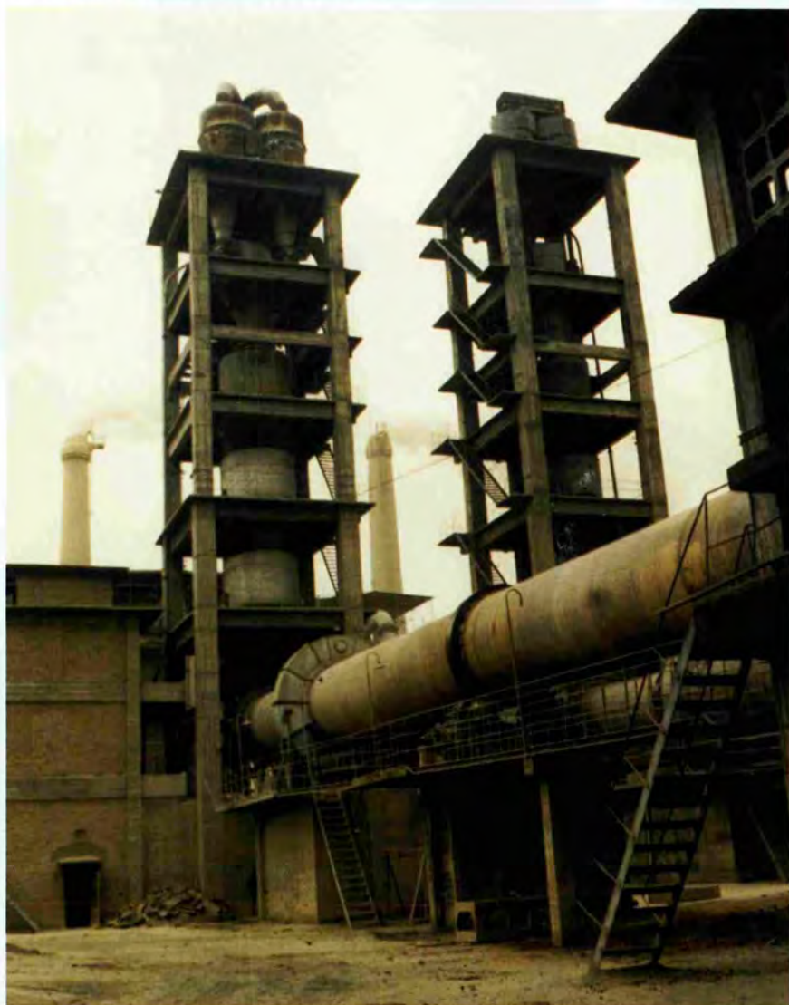
由天津水泥工业设计院和泾阳县水泥厂合作开发建设的旋风预热器回转窑水泥生产线。1982年被国家建材工业局命名为“泾阳窑”。
