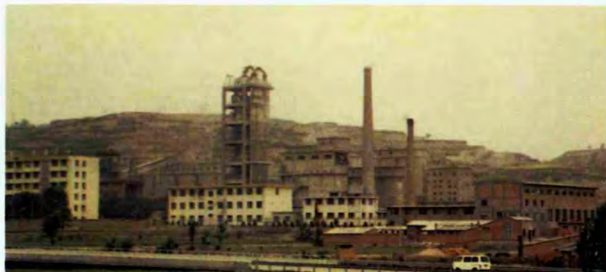
1974年，陕西省煤炭建设公司建材厂在陕西省小水泥企业中首先采用 2.7 \times 45\text{m} 回转窑建成的水泥生产线。
