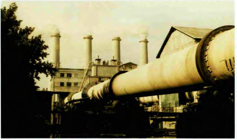
1-4号窑湿法水泥生产线
