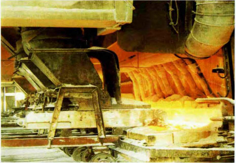
陕西玻璃厂九机垂直引上普通平板玻璃生产线
