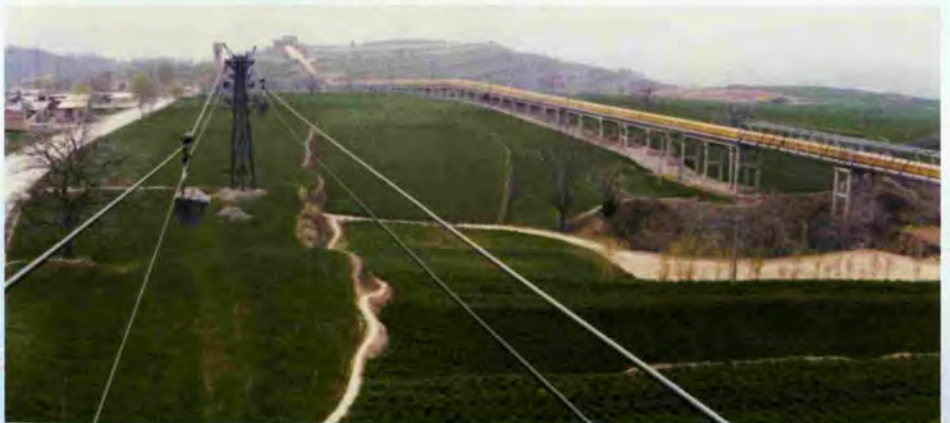
矿山原料输送架空索道和皮带廊
