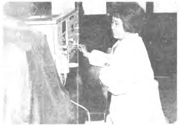
用原子分光光度计测定出口陶瓷中含铅微量
