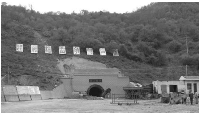
引红济石工程关山引水枢纽
