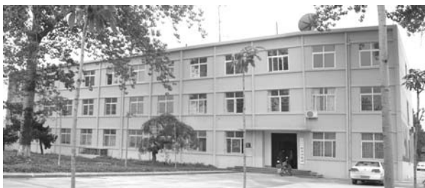
西北农林科技大学眉县试验站
