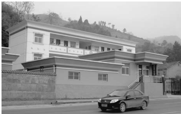
太白县鸚鵡木材检查站
